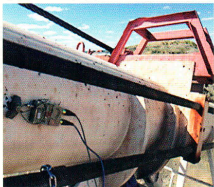
Рис. 5. Расположение ПАЭ вблизи элементов крепления работающей лебёдки
